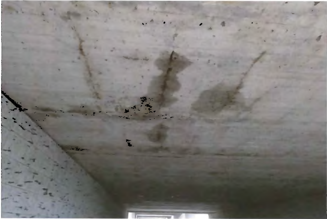
Désordre n° 3, éclatement du béton par oxydation des aciers
