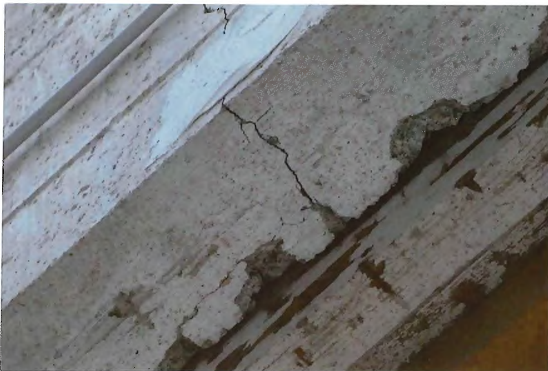
Désordre n° 1, fissuration sur poutre échelle
