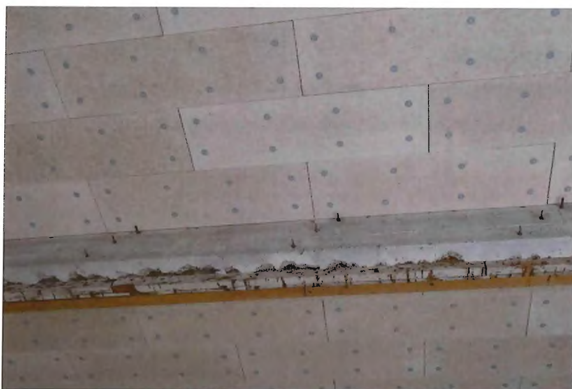
Désordre n° 2, éclatement du béton sur les retombées de poutres
